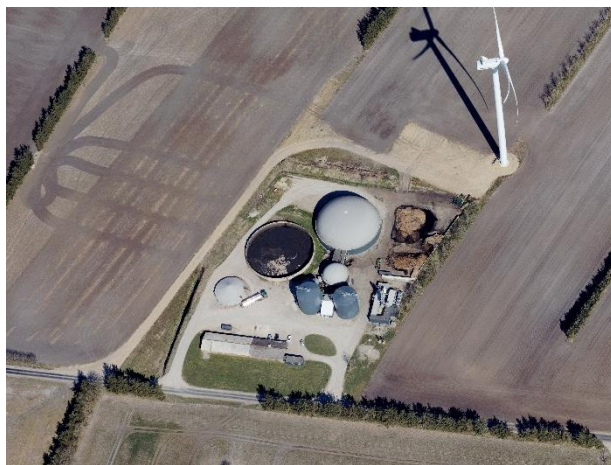
Det eksisterende biogasanlæg på Gundesbølvej. @SDFE
