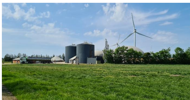
Det eksisterende biogasanlæg på Gundesbølvej set fra sydøst.
